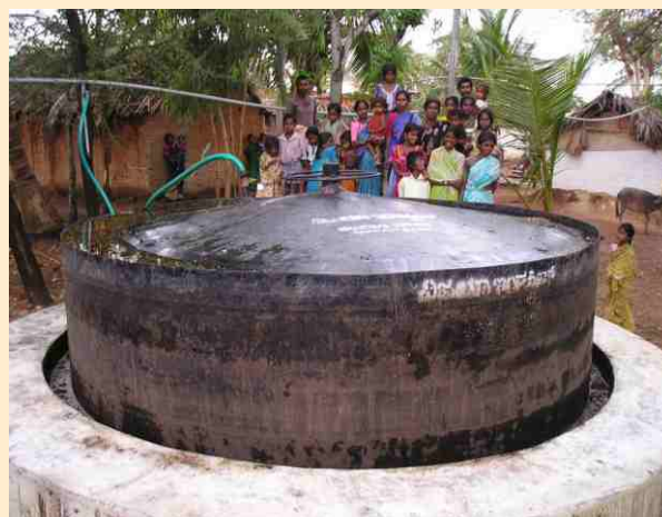
20 cmtr community biogas plant, K. Gollarahatti (Koratagere)
